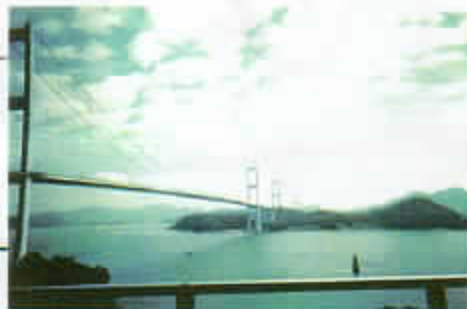
【来島海峡大橋】
